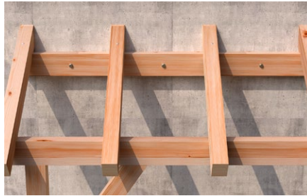
Strutture in legno.
