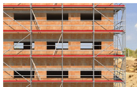
Ponteggi di facciata.
