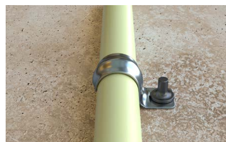
Fissaggio di tubi.
